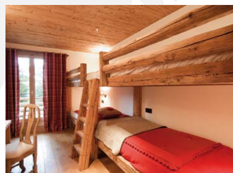
Balken, Sparren und 3-Schicht-Platten von original gehackten Balken
