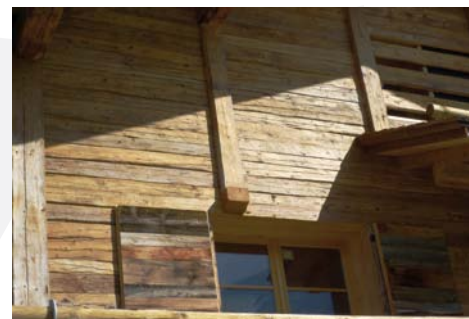
Fasadenverkleidung aus Brettern mit handgehackter Oberfläche
